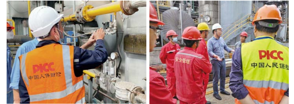
人保财险浙江省嘉兴分公司为园区企业提供安全隐患排查服务
