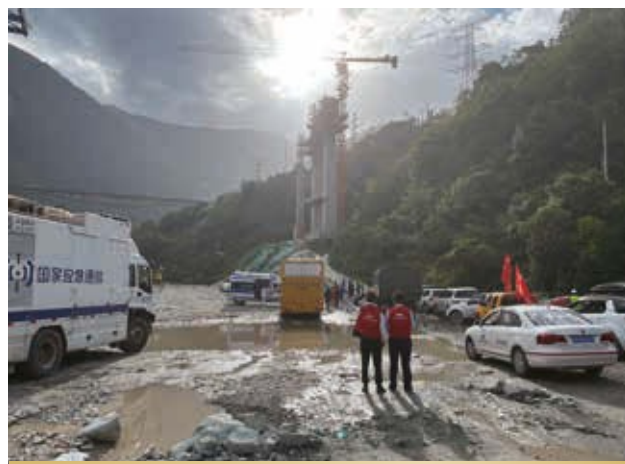
人保财险迅速应对四川甘孜州泸定县6.8级地震
